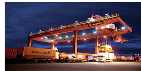
Kran i arbeid på dagens terminal. (Foto: CargoNet)
